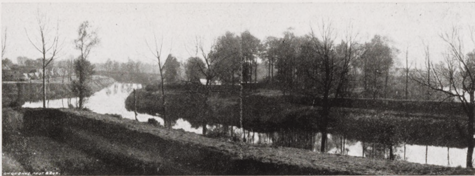
396. Etat des remparts Sud en 1918.
